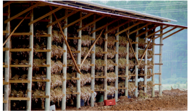
Barracão de cura tradicional, com a aba lateral de proteção ao sol e chuva
